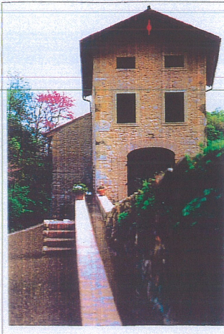
Foto 1: La Roggia con fronte principale del Mulino
