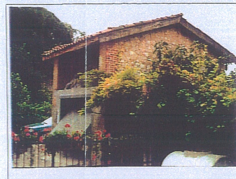
Foto 4: vista corpo (c)
