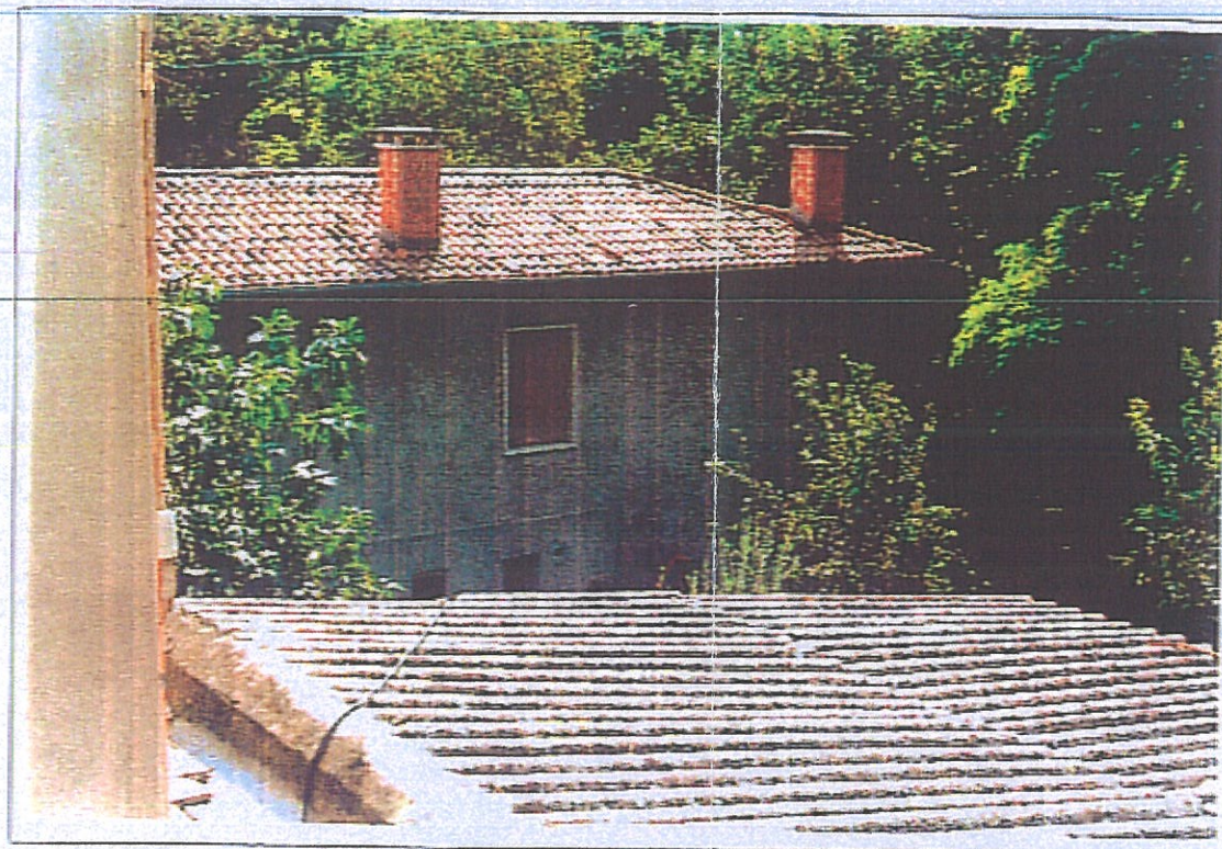
Foto 2: corpo (b) vista a monte
