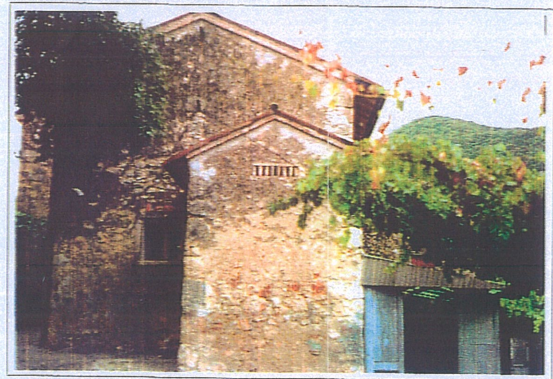
Foto 4: fronte laterale corpi (a) (b) (c)
