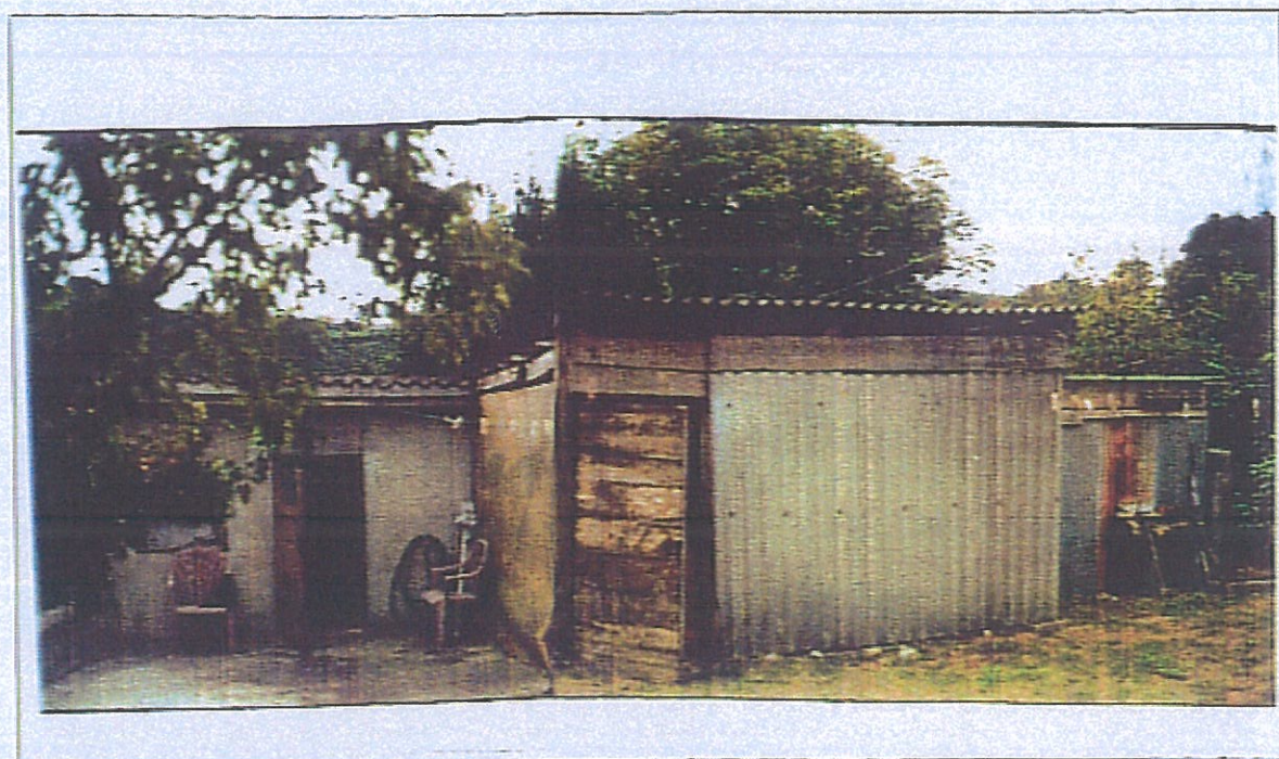
Foto 3: vista elementi precari (e)
