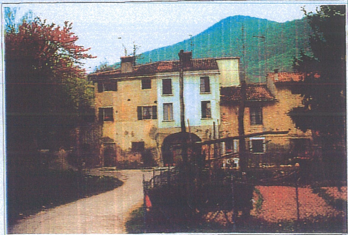
Foto 1: blocchi (a), (b), (c) vista sulla corte
