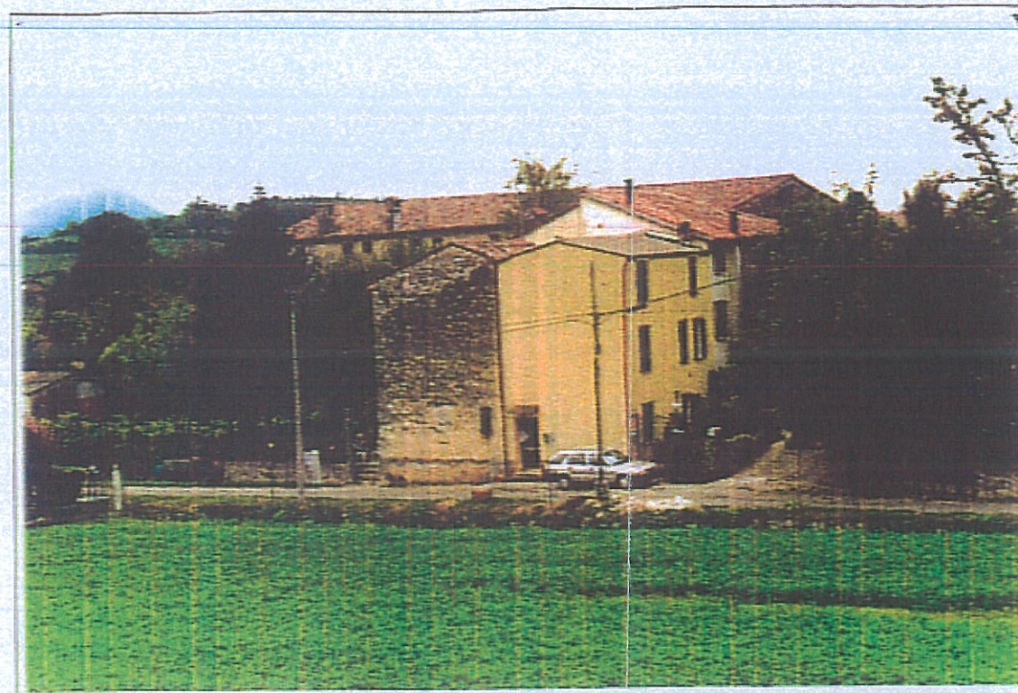
Foto 2: vista del complesso
