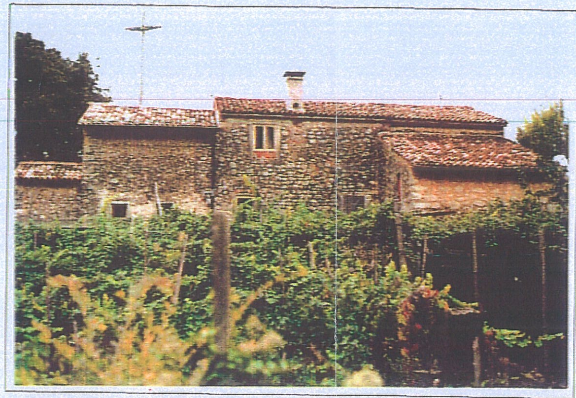
Foto 2: fronte a monte corpi (a) (b) (c) (d)
