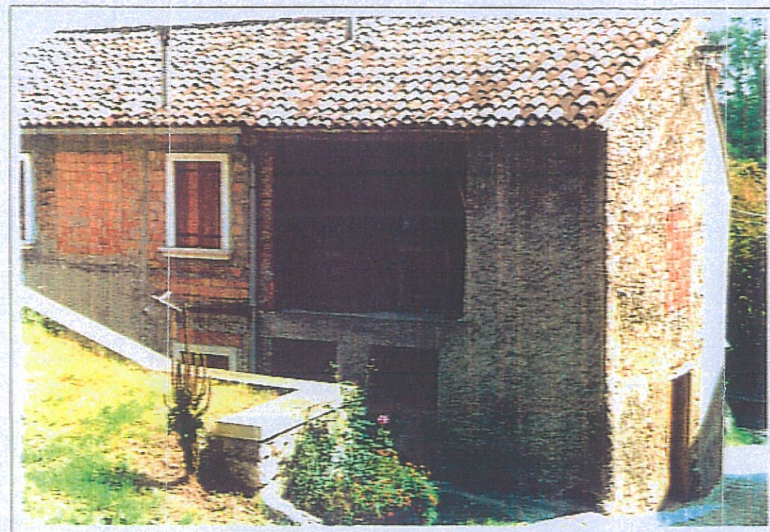
Foto 2: vista fronte a monte corpo (a)
