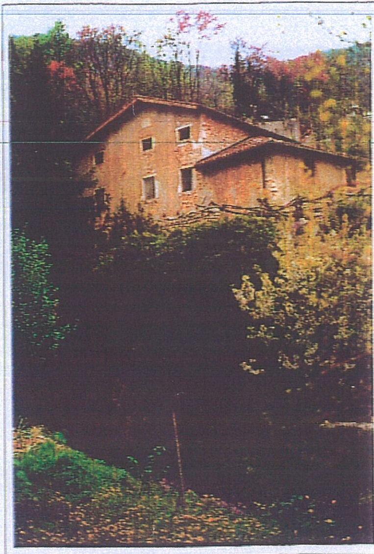
Foto 1: vista del complesso
