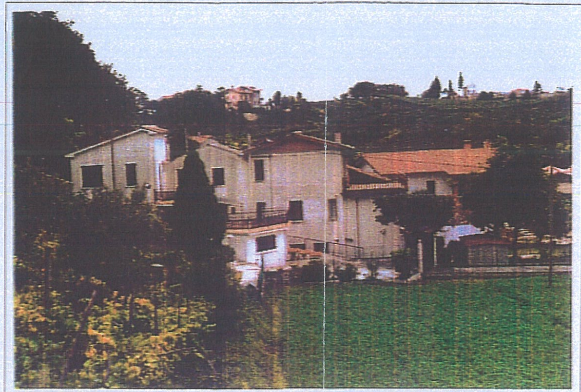
Foto 2: fronte laterale dei corpi (a) (b)
