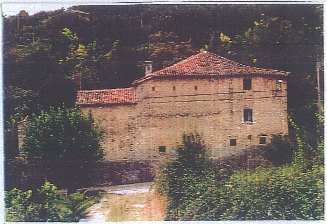
Foto 3: fronte laterale lungo la strada
