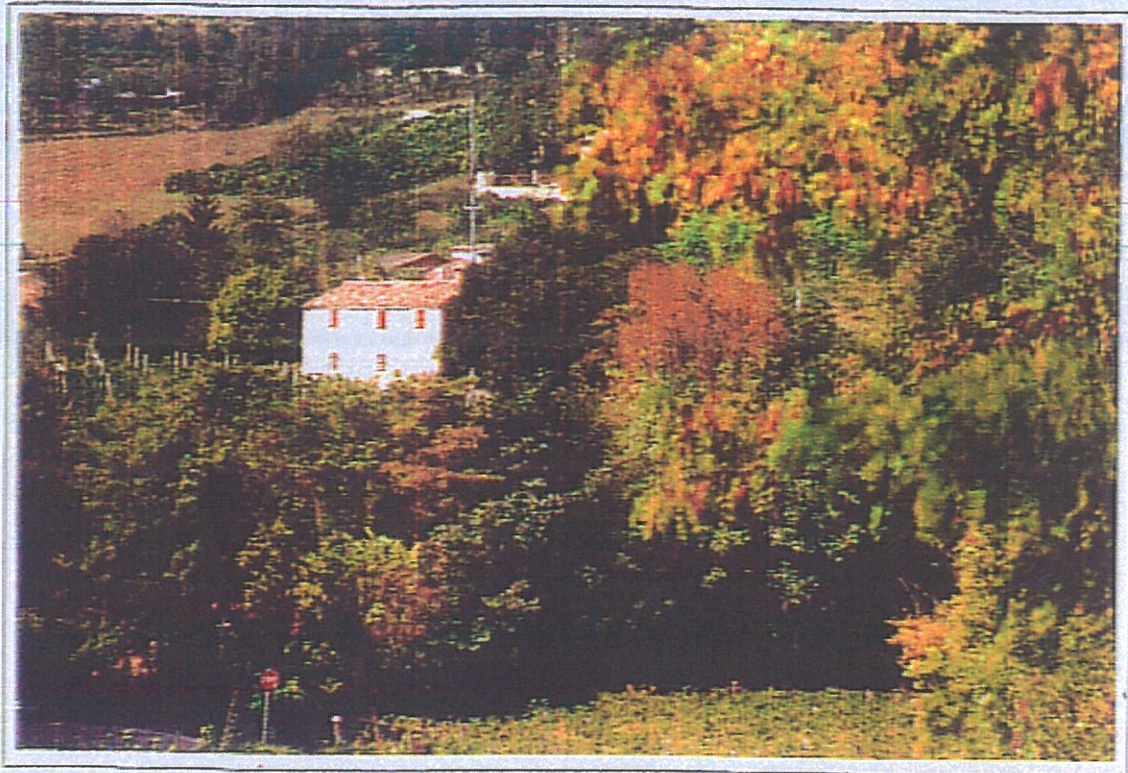
Foto 1: vista panoramica da valle corpo (a)
