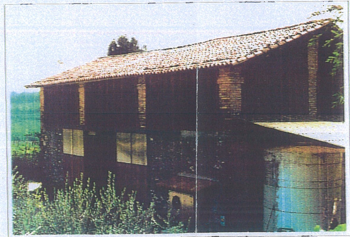
Foto 4: fronte sulla corte corpo (d)
