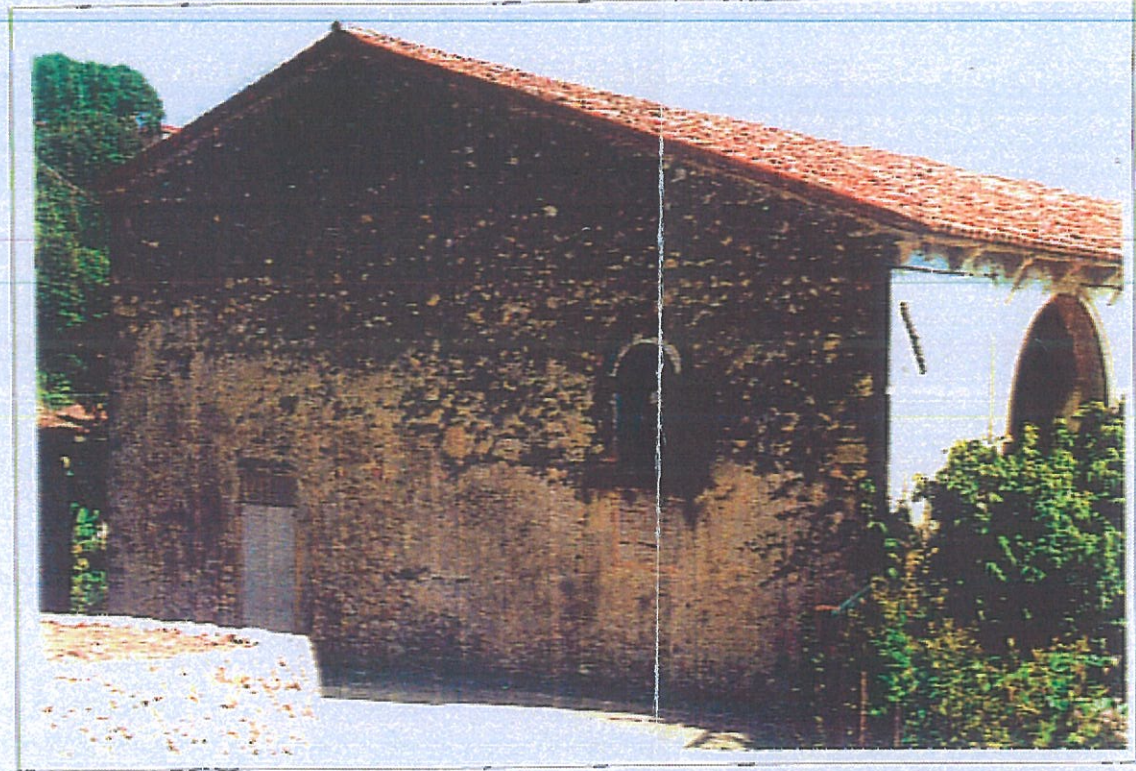
Foto 2: fronte a monte corpo (b)
