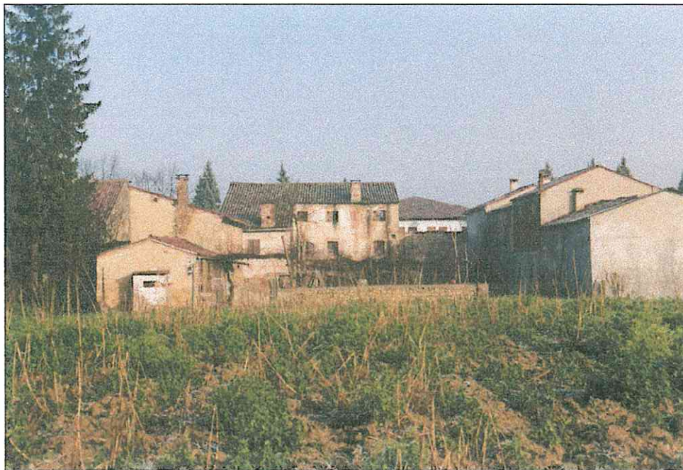
FOTO 1: veduta del complesso – in primo piano tratto di mura dello stabile demolito
