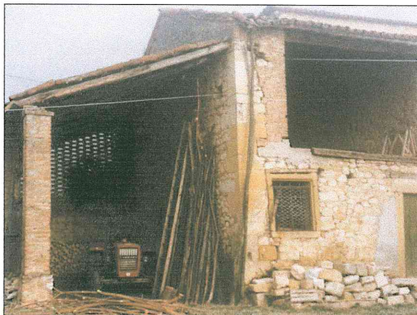
FOTO 1: vista da sud del portico oggetto d'intervento
