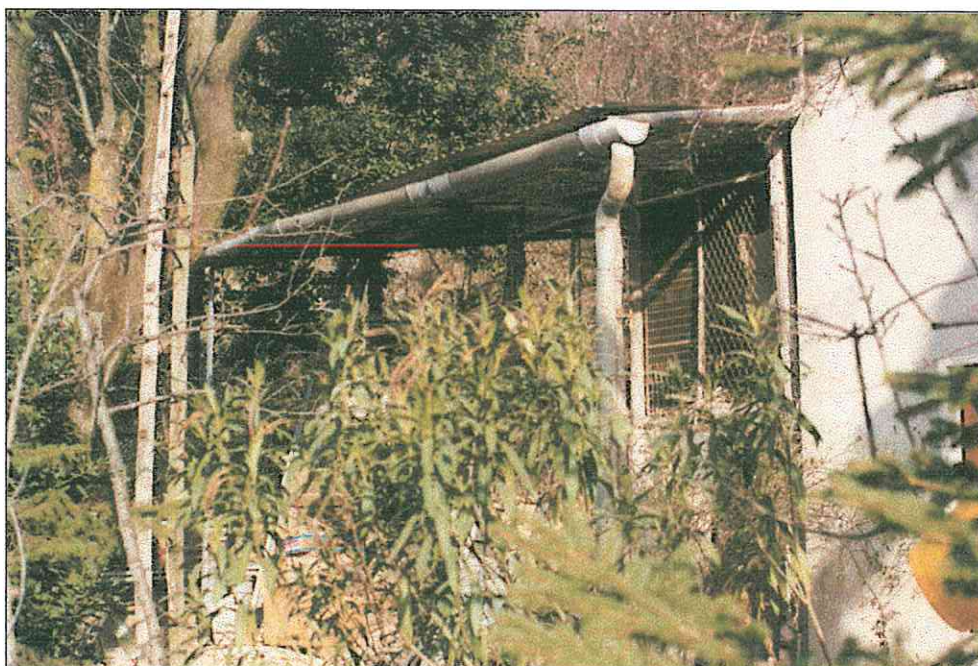
FOTO 2: vista del lato ad annessi oggetto d'intervento A
