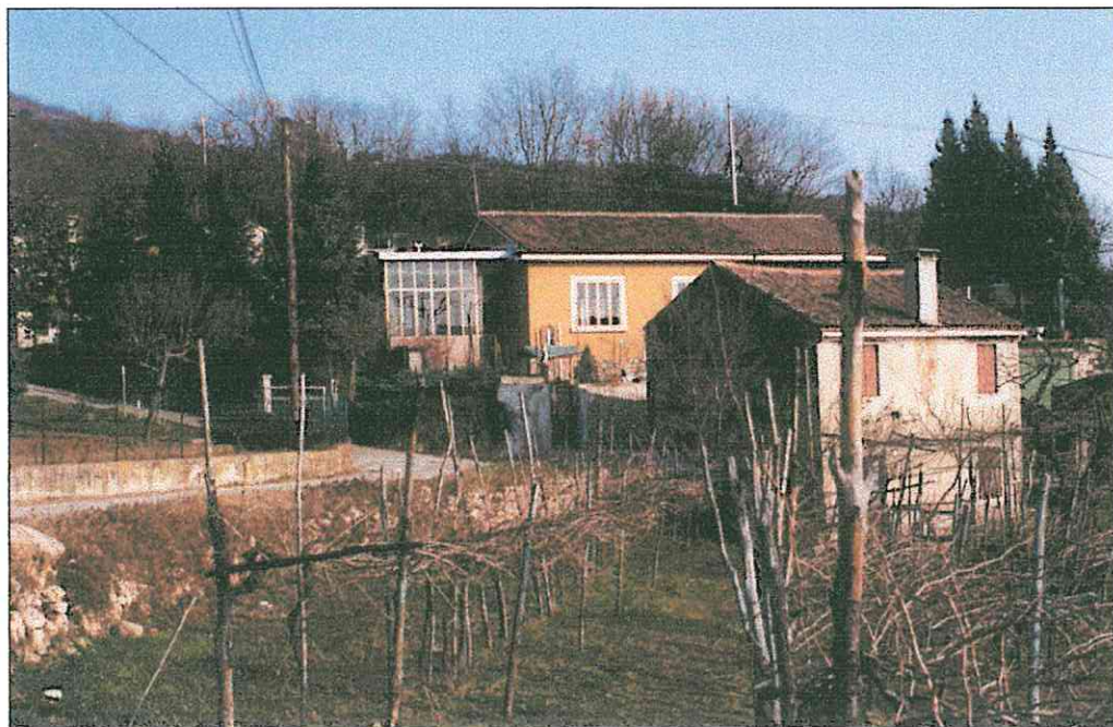
FOTO 1: vista complessiva dell'immobile oggetto d'intervento.
