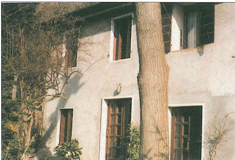
FOTO 1: vista del blocco centrale a residenza
