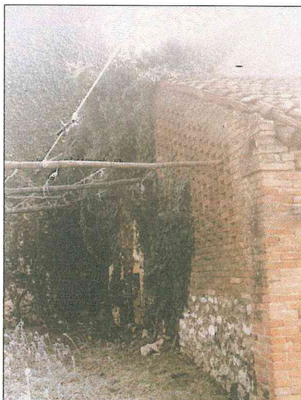
FOTO 2: particolare – parete nord
