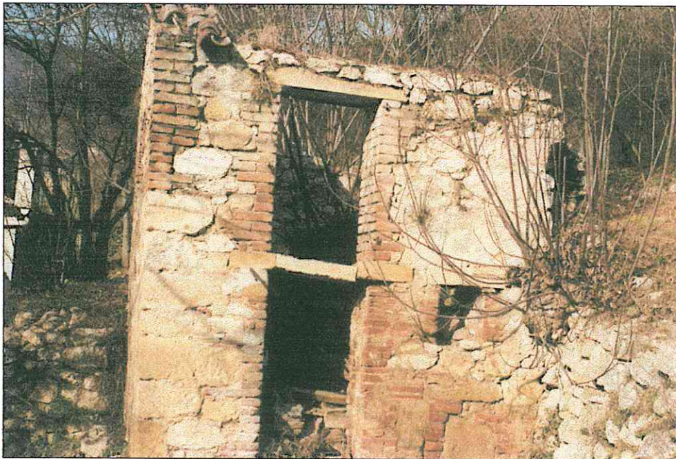
FOTO 1: vista frontale dell'annesso.
