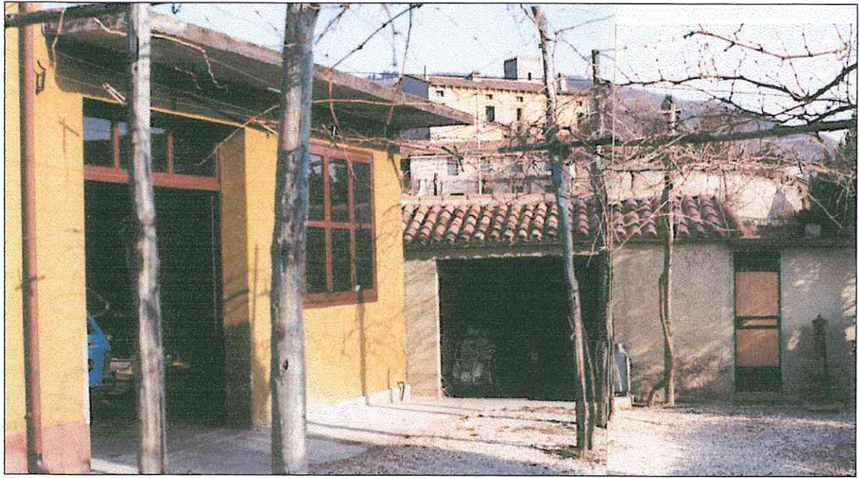
FOTO 1: deposito + locali di servizio
