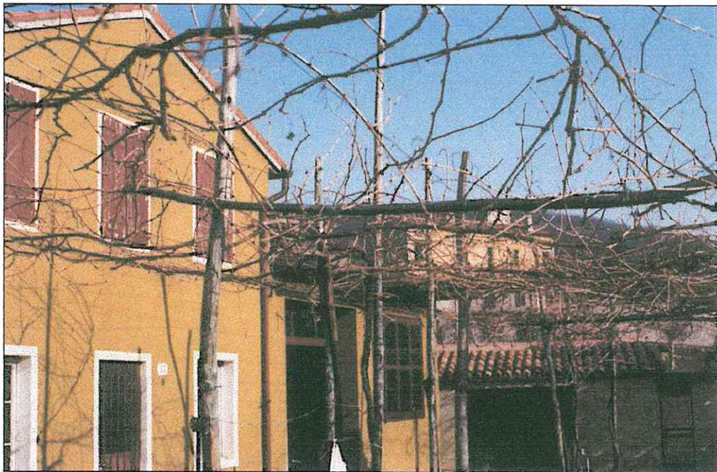
FOTO 2: vista comprendente parte di A
