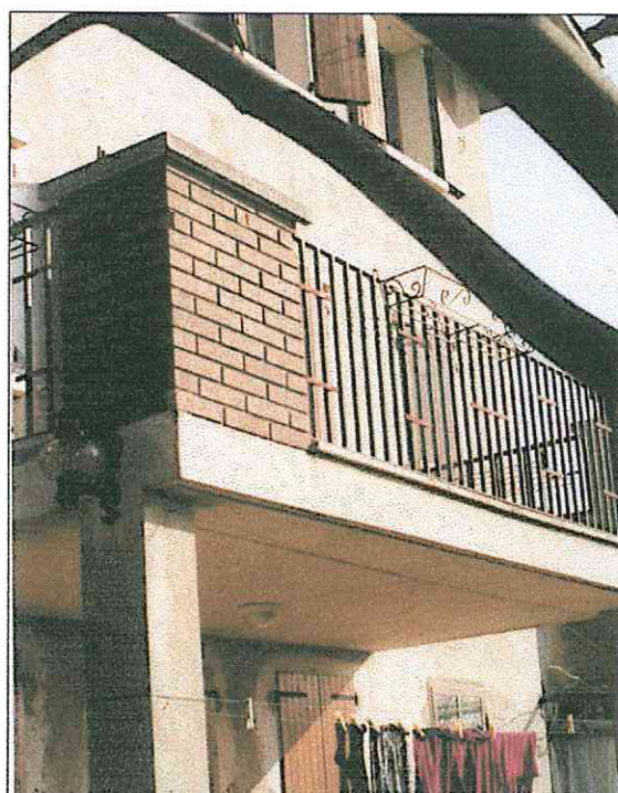
FOTO 2: il terrazzo sul fronte sud
