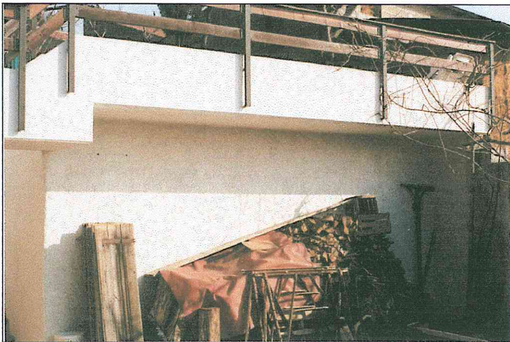
FOTO 1: descrizione della parete in cui ricavare l'ingresso al nuovo garage
